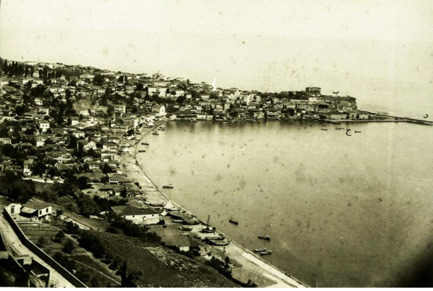
Foto 18: Çömlekçi Mahallesi (Çömlekçi District)
