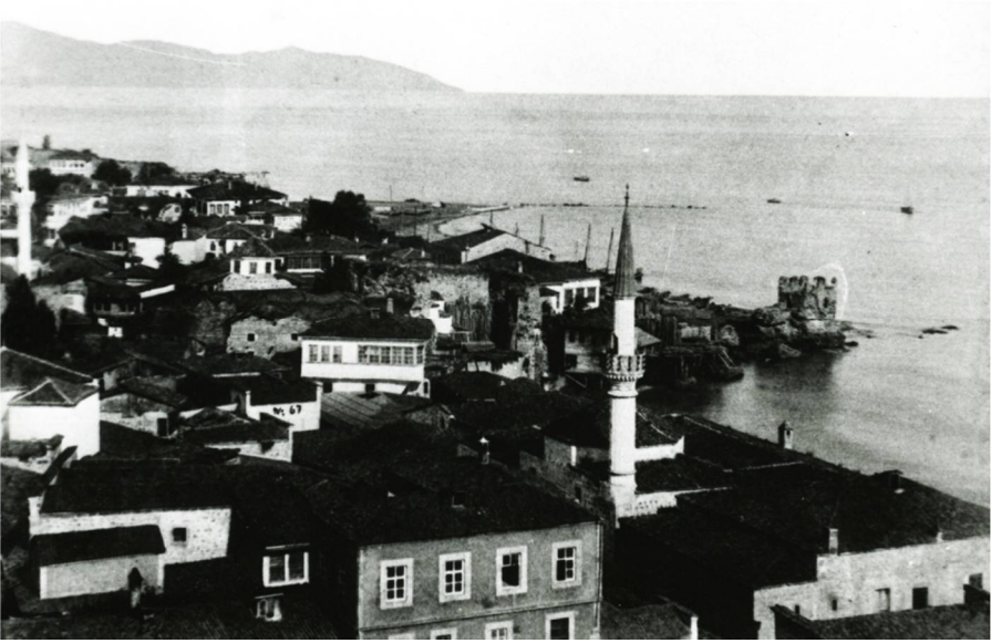
Foto 19: Çömlekçi Mahallesi (Çömlekçi District)
